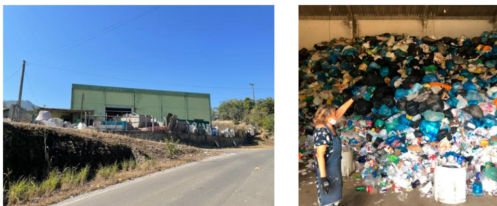
Imagens 4 e 5 - Espaço de Armazenamento dos RS
